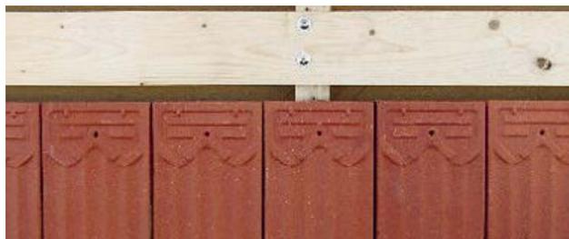
**Wichtig:** Die Dachlatte wird bis Ausserkante Konterlatte zurückgeschnitten. Zusätzlich wird ein Stück Dachlatte ca. 20 cm seitwärts in die Konterlatte genagelt.
