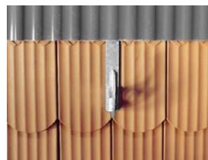
Der SH AGZ Sicherheitshaken ist nach EN 517 Typ B geprüft und kann in allen Belastungsrichtungen verwendet werden.
