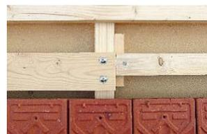
**Wichtig:** Das oberste Schraubenloch muss über der Konterlattung eingemittet sein. Bei einer Durchdringung der Schrauben durch das Unterdach muss dies gem. Norm SIA 232 /1, (Ziff 2.2.10.3) dicht sein. Der SH AGZ Sicherheitshaken wird mit 3 Stk. 8 x 80 mm Tellerkopfschrauben durch die Dreischichtplatten in die Konterlatte befestigt.
